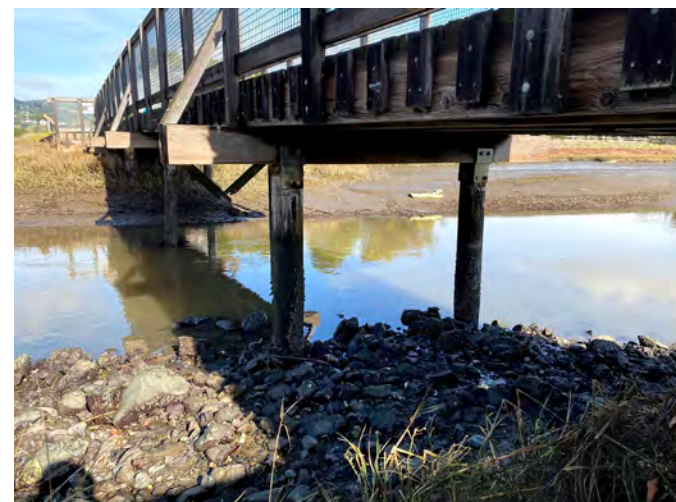
BRIDGE 3 - ARROYO CORTE MADERA DEL PRESIDIO
