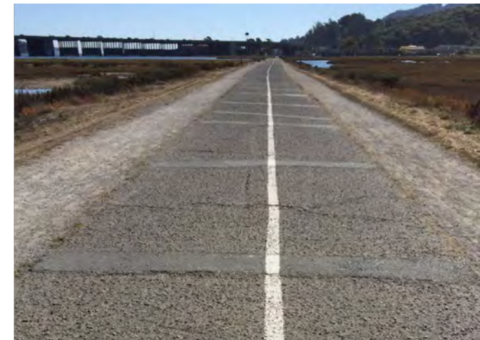
THERMAL CRACKING
